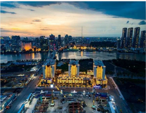
Dự án: METROPOLE THỦ THIÊM Nhà thầu: Công ty CP XD COTECCONS Project: METROPOLE THU THIEM Contractor: COTECCONS Construction Joint Stock Company
