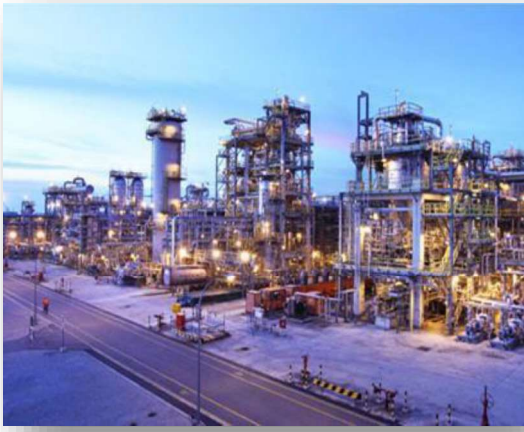
Dự án: Tổ hợp lọc hóa dầu Long Sơn Liên danh thầu chính TPSK Project: Long Son Petrochemical Refinery Complex TPSK main contractor consortium
