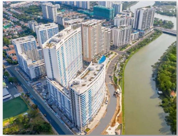
Dự án: MIDTOWN M8 Phú Mỹ Hưng Nhà thầu: Công ty CP Tập đoàn XD Hòa Bình Project: MIDTOWN M8 PHU MY HUNG Contractor: Hoa Binh Construction Group Joint Stock Company
