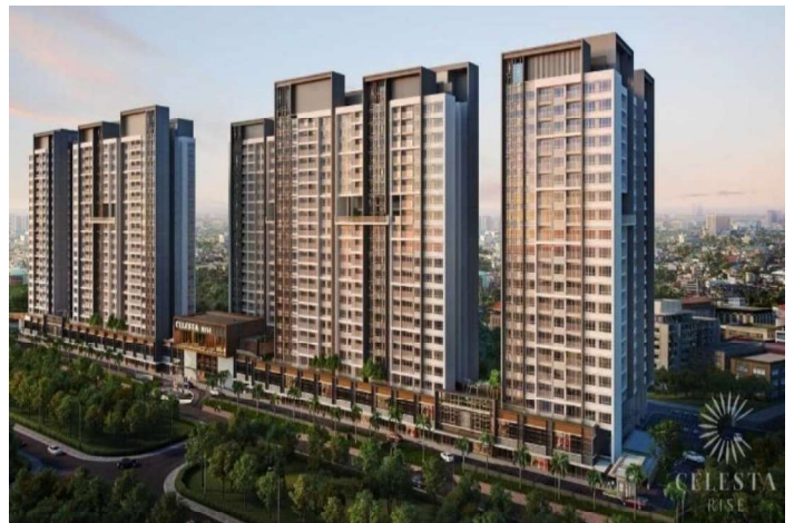
Dự án: CELESTA RISE Nhà thầu: Công ty CP Tập đoàn XD Hòa Bình Project: CELESTA RISE Contractor: Hoa Binh Construction Group Joint Stock Company
