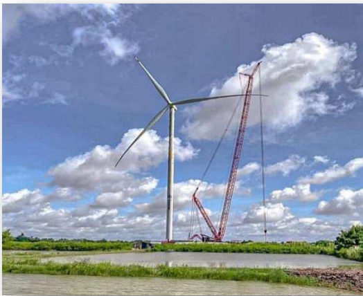
Dự án: Điện gió Lạc Hòa Nhà thầu: Công ty CP FECON Project: Lac Hoa Wind Power Contractor: FECON Joint Stock Company
